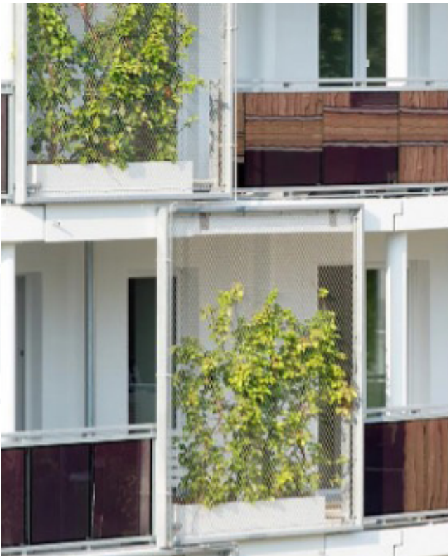
Netzkonstruktion, Rahmenprofil (Quelle: Jakob Rope Systems)
