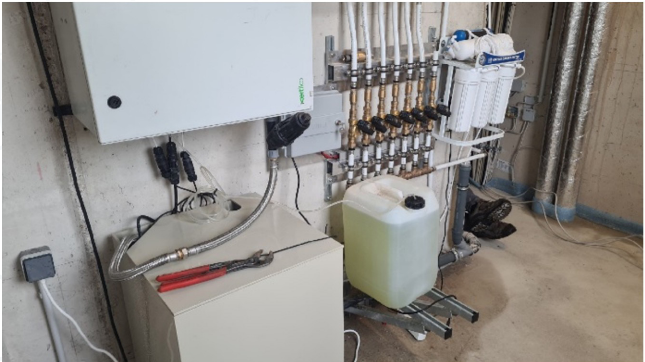
Beispiel einer Bewässerungsanlage mit 7 Bewässerungskreisen und automatischer Entleerung (© Vertiko, 2023)
