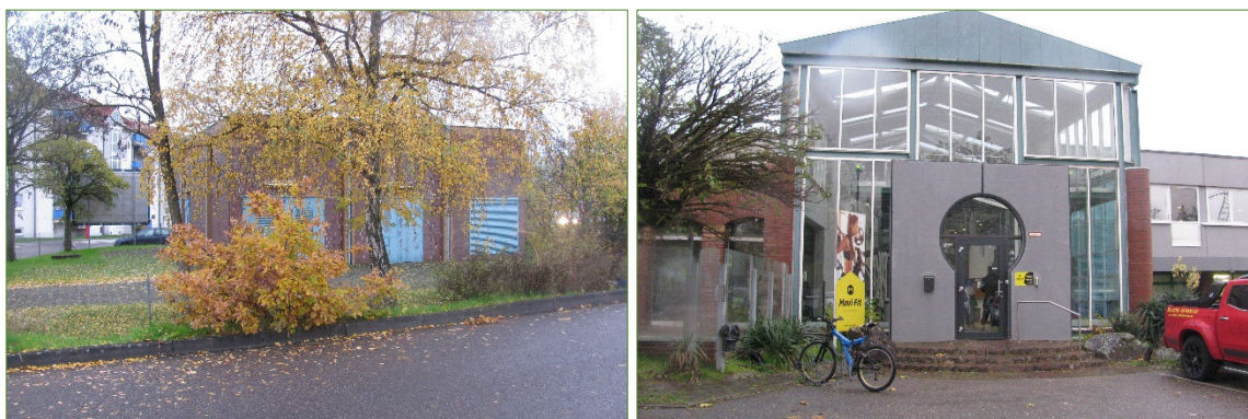
Abbildung 4 und 5: Trafostation (links) und Fitness-Studio (rechts) (Quelle: ARGUS CONCEPT GmbH)
