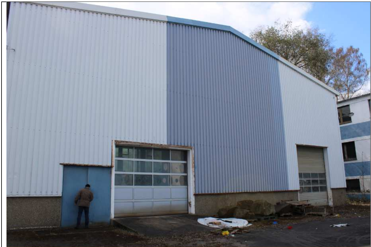
Foto 1: Metallbauweise der Hallen
