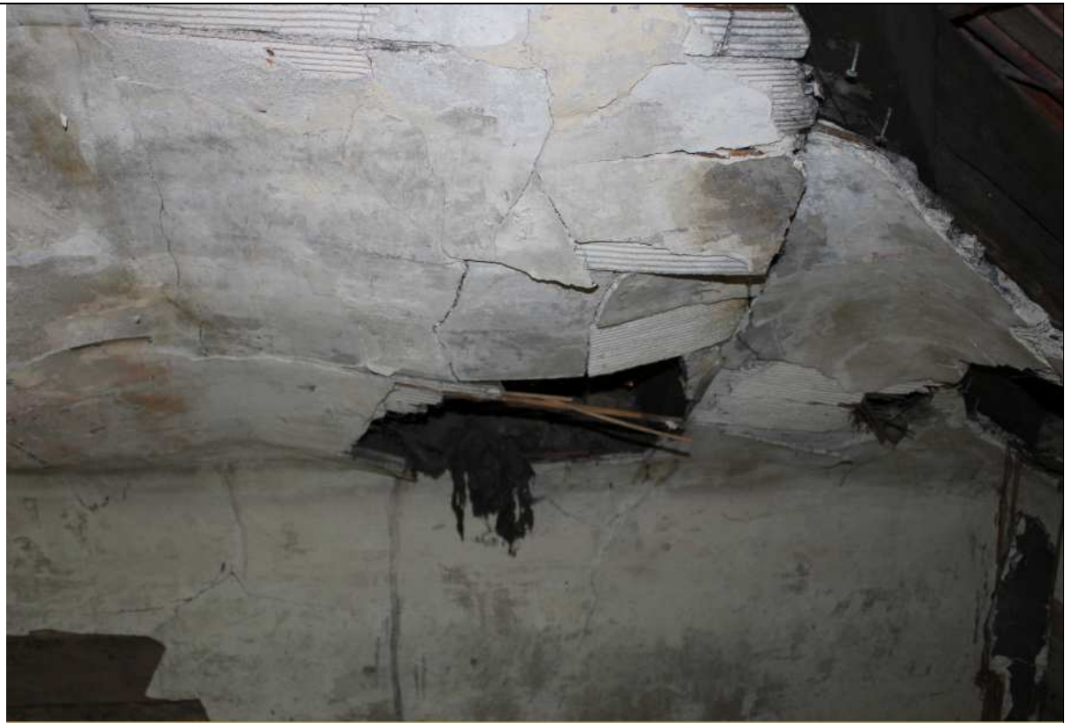
Foto 5: Rohrmattendecke im Dachstuhl des Gebäudes „Konstruktion“
