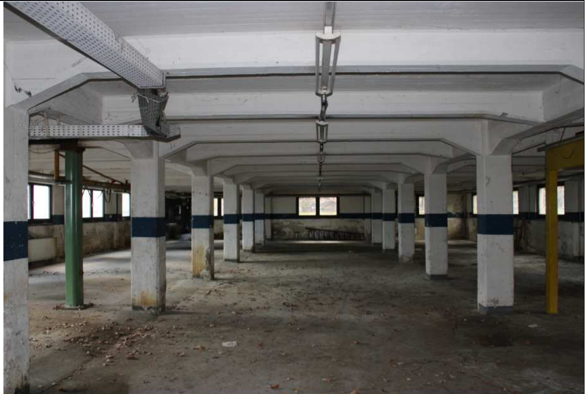
Foto 3: Entkerntes Gebäude „Betonbau“ ohne Quartierstrukturen
