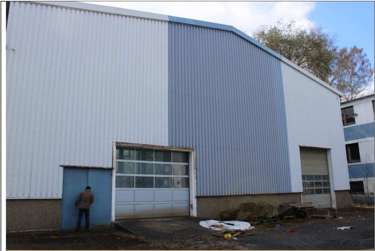
Foto 1: Metallbauweise der Hallen
