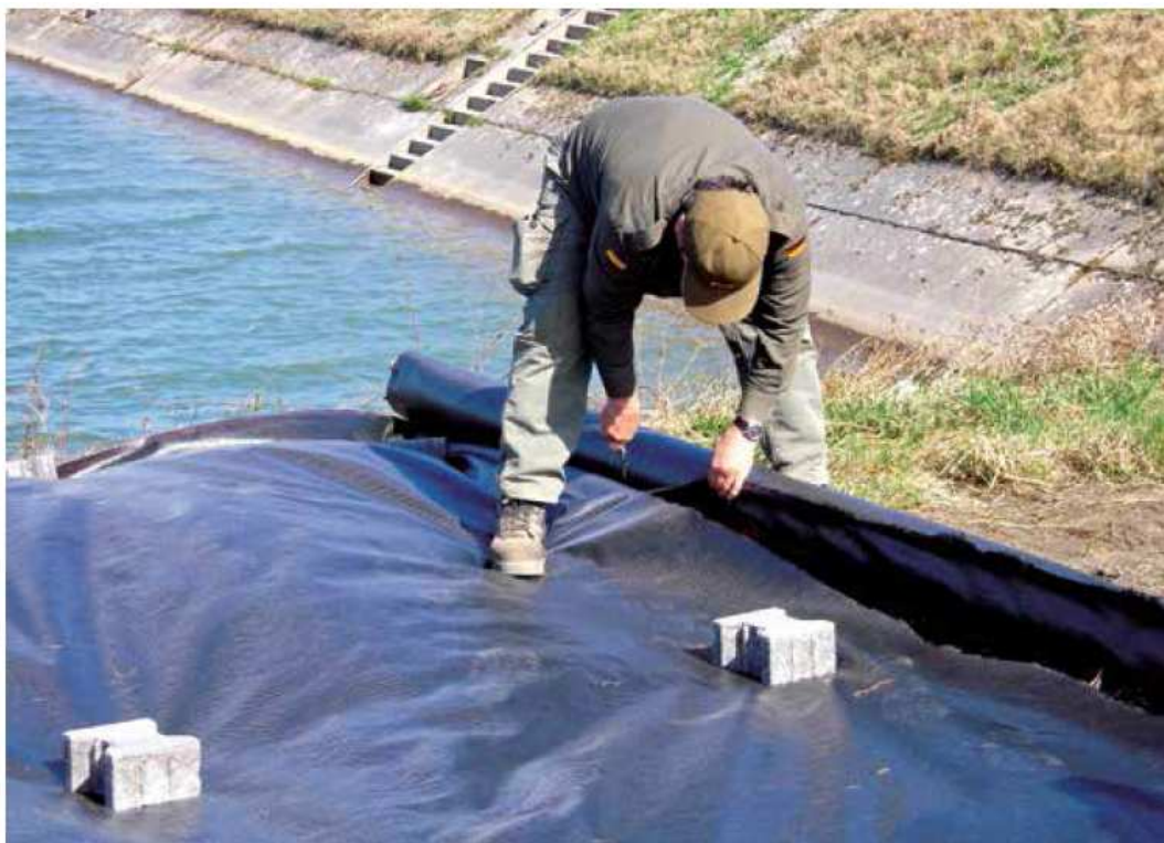
Abb. 3: Eine effiziente Methode, die Sonne liebenden Reptilien aus dem Bereich von kleineren Eingriffsflächen zu lenken, ist das Abdecken (zzgl. Pufferbereich) mit lichtundurchlässiger Folie nach Aktivitätsbeginn der Arten im Frühjahr und vor der Paarungszeit oder nach Ende der Eizeitigung bzw. Schlupf der Jungtiere Anfang August bis vor Überwinterungsbeginn Anfang Oktober.
