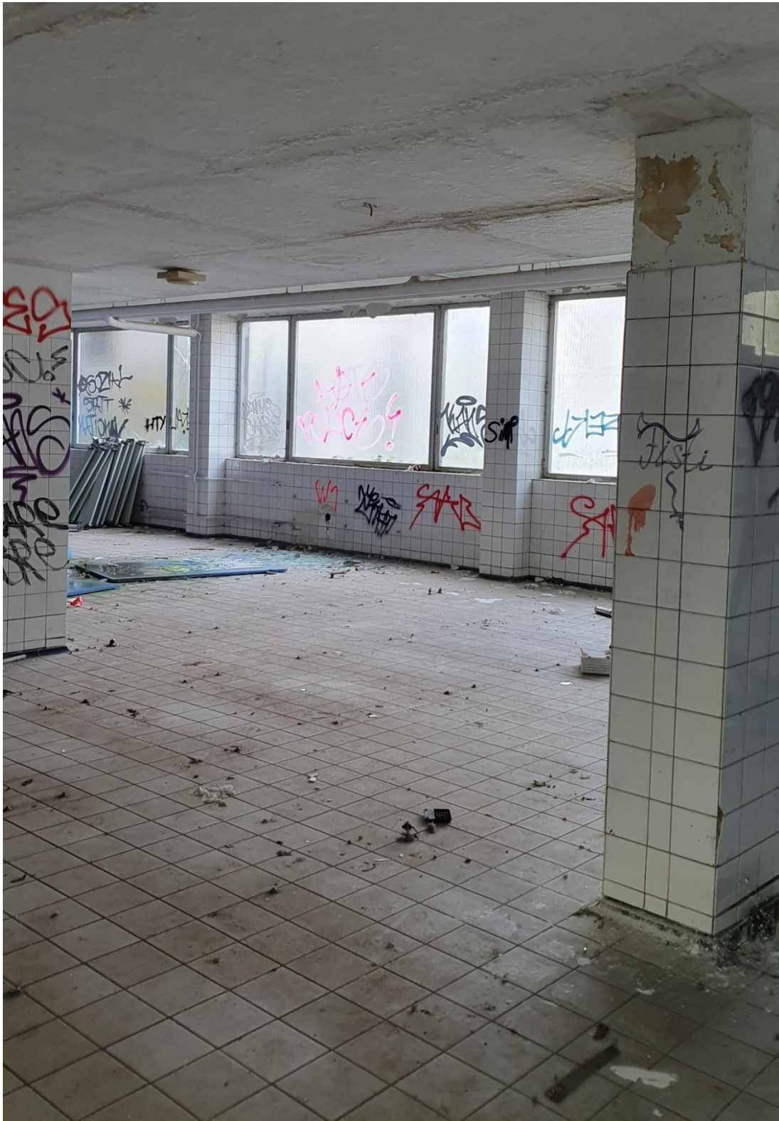
Abb. 3-4: Umkleide im Erdgeschoss
