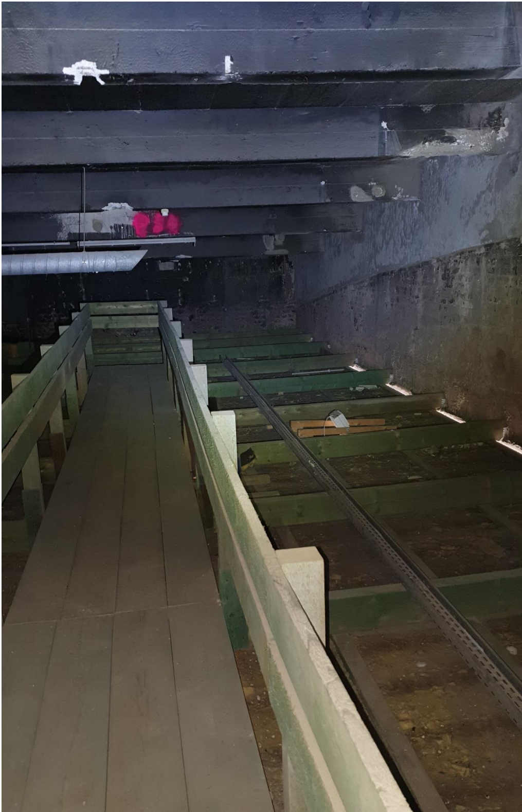
Abb. 3-7: Betondecke des Dachgeschoss des Hauptgebäudes
