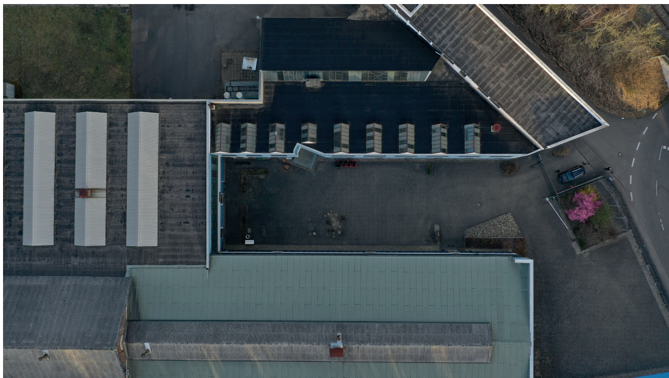
Drohnenaufnahme des Plangebietes mit der Bestandsbebauung der ehem. Firma „Neumann Präzisionstechnik“; Quelle: Kernplan GmbH
