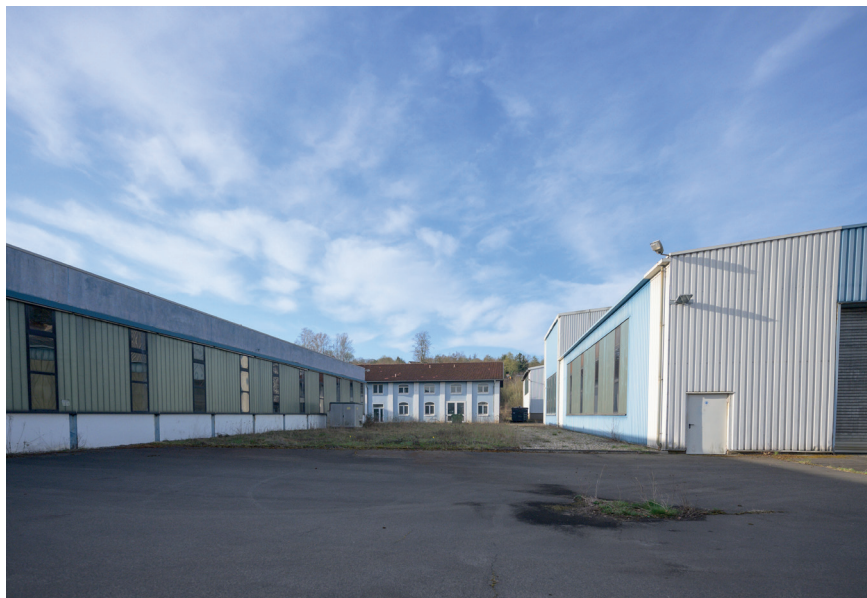
Bestandsbebauung der ehem. Firma „Neumann Präzisionstechnik“; Quelle: Kernplan GmbH
