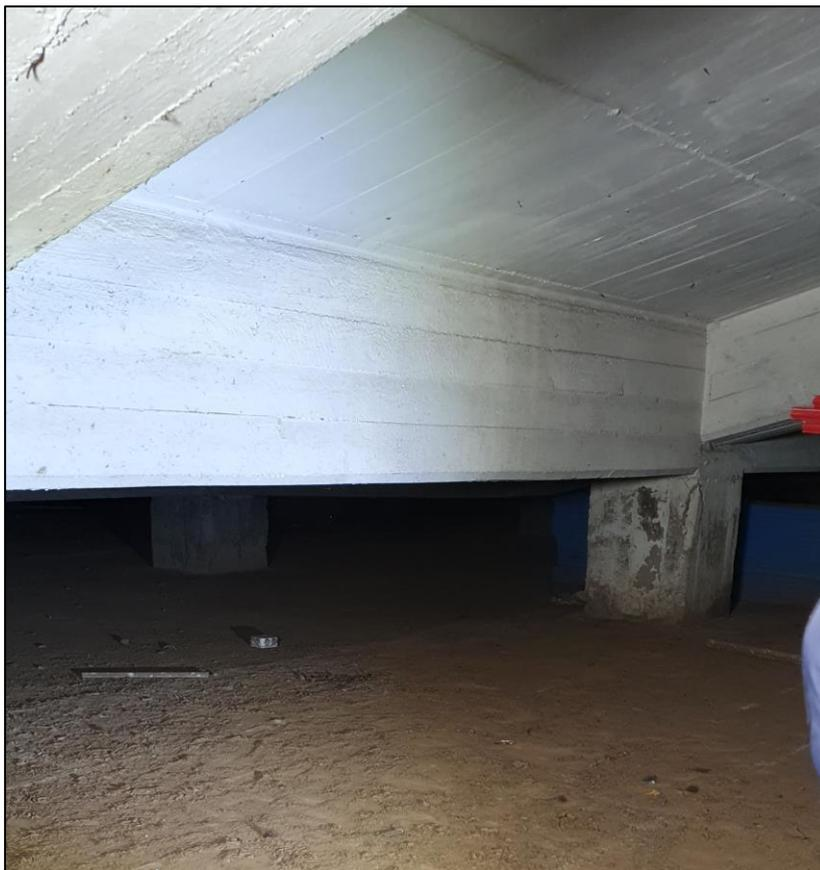
Die Gebäude liegen innerhalb einer wasserdichten Grundwasserwanne aus Beton, um das Eindringen von Grundwasser aus dem nahegelegenen Rischbach zu verhindern.
