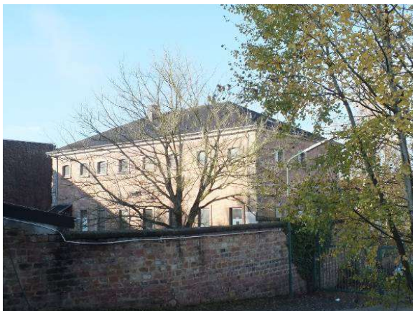
Mauer zwischen ehem. JVA und westlicher Zufahrt zur Baumwollspinnerei
