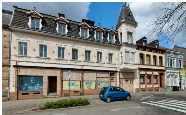
Alte Bahnhofstraße 20-24 (Ensembleschutz)
