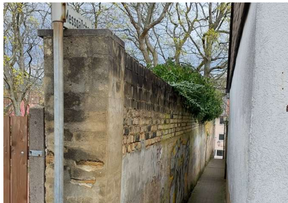
Messgässchen (fußläufige Verbindung nach Osten: Alte Meßstraße - Pfarrgasse)
