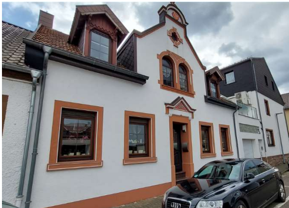
Saniertes Wohnhaus Auf der Meß 20
