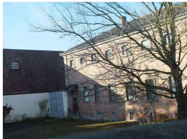
Rückansicht der ehem. JVA und Südmauer
