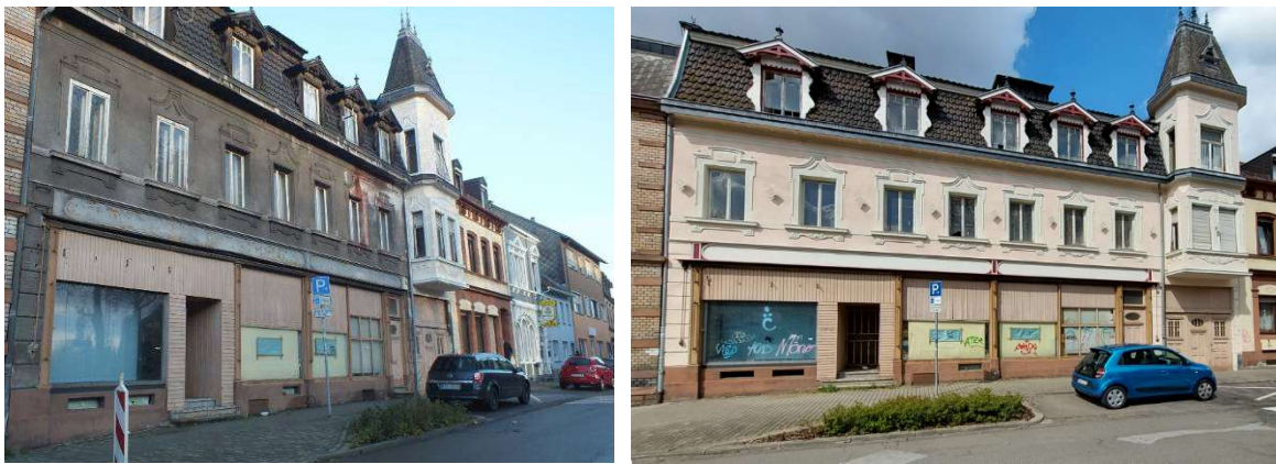
Alte Bahnhofstr. 24 (vor der Fassadensanierung 2013 und Zustand im April 2022)
