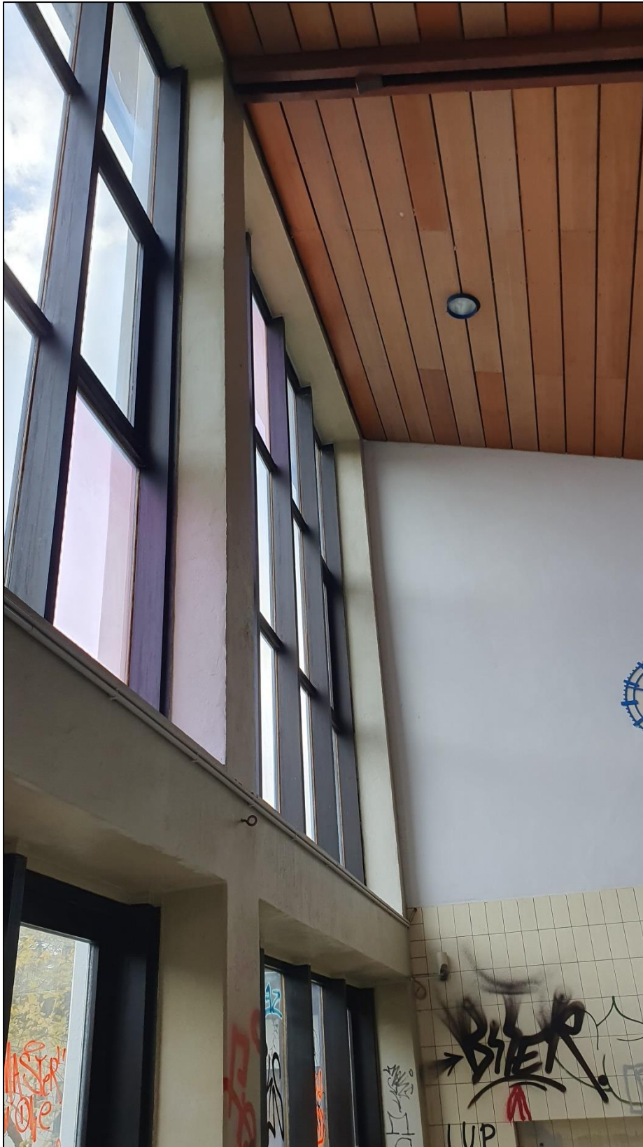
Abb. 3-6: Decke / Außenwand der Schwimmhalle
