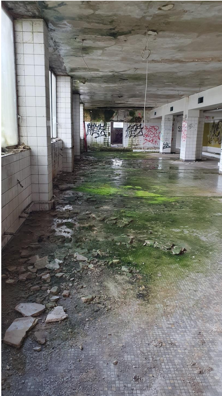
Abb. 3-9: Innenansicht des Seitengebäudes
