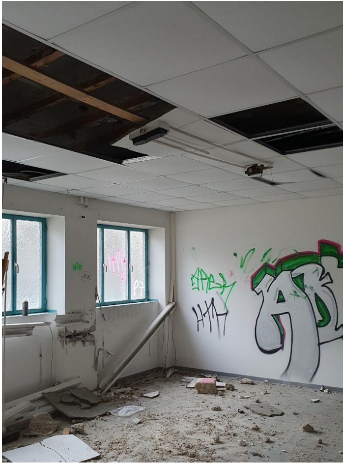
Abb. 3-8: Innenansicht des Seitengebäudes
