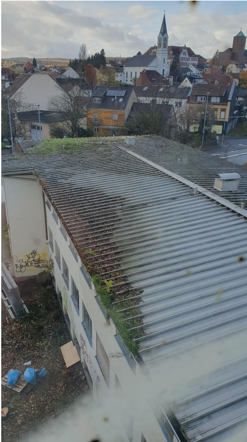
Abb. 3-10: Blick vom Turm auf das Dach des Seitengebäudes
