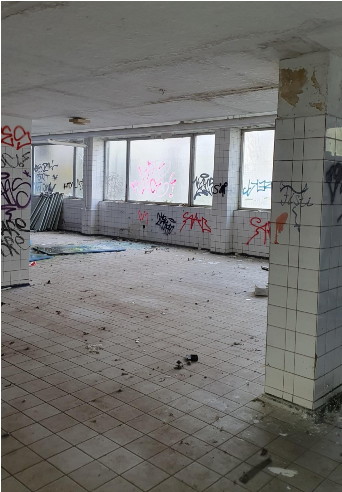
Abb. 3-4: Umkleide im Erdgeschoss
