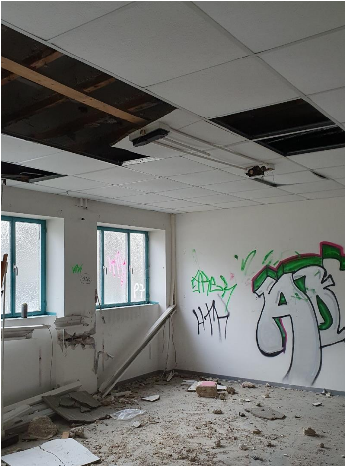
Abb. 3-8: Innenansicht des Seitengebäudes
