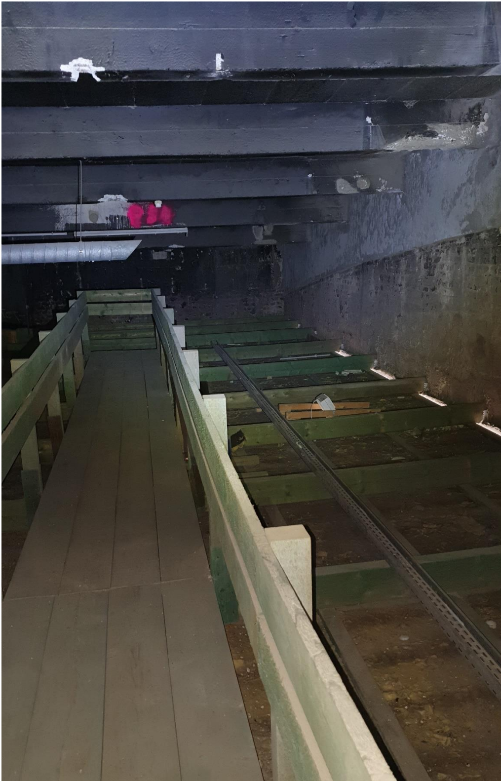
Abb. 3-7: Betondecke des Dachgeschoss des Hauptgebäudes
