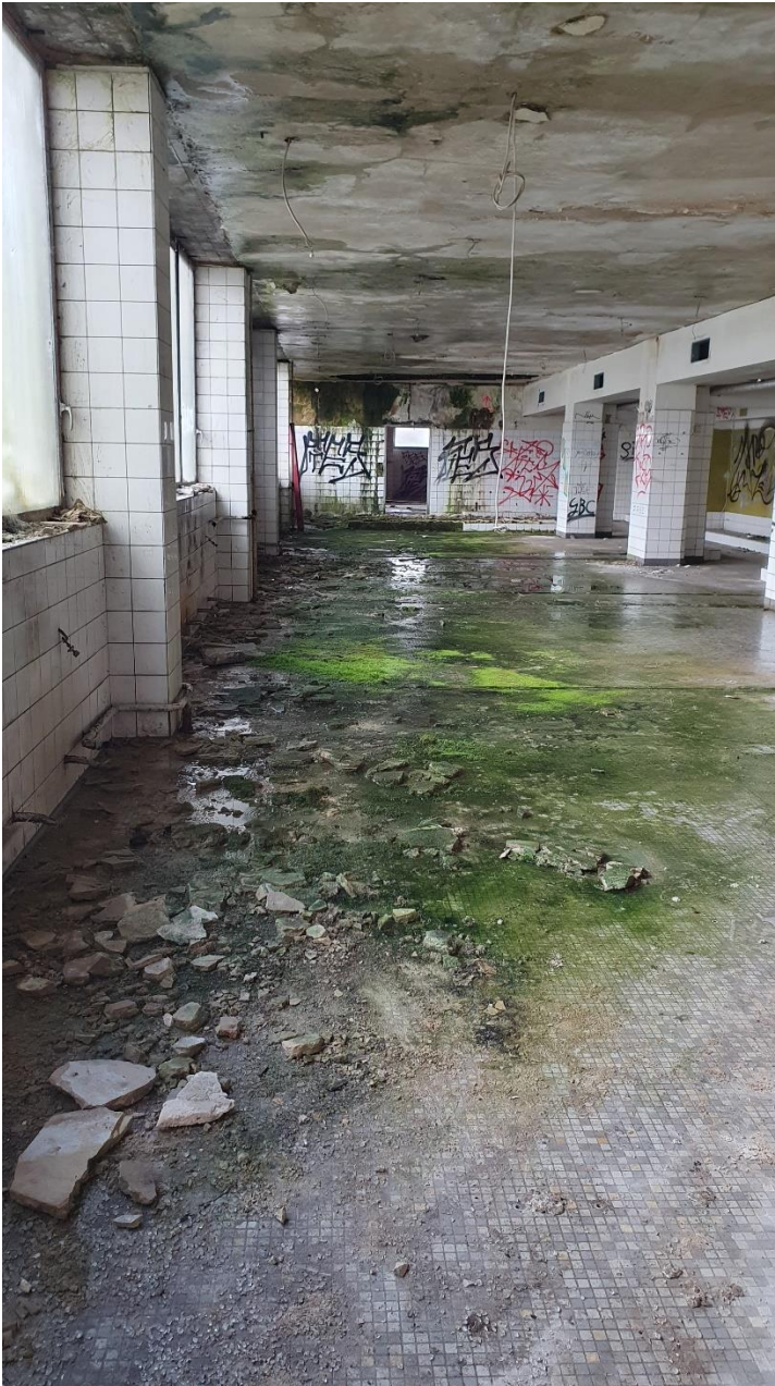
Abb. 3-9: Innenansicht des Seitengebäudes
