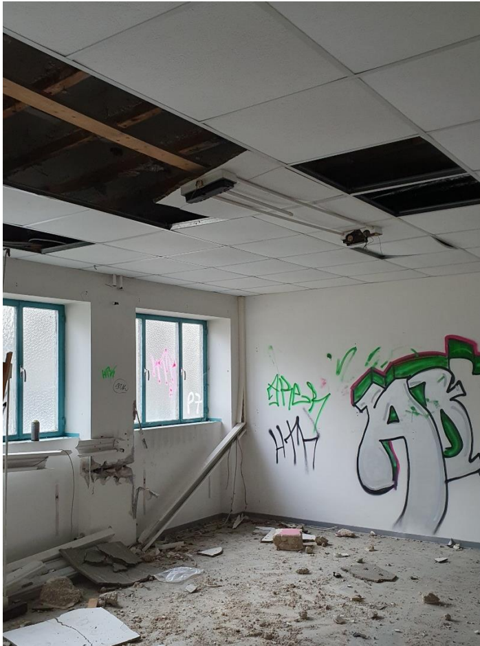
Abb. 3-8: Innenansicht des Seitengebäudes
