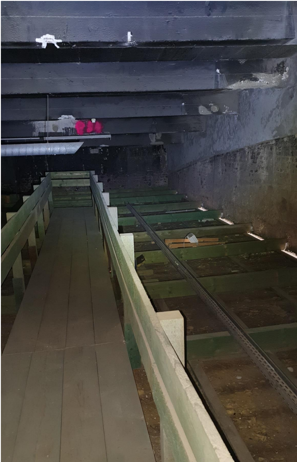
Abb. 3-7: Betondecke des Dachgeschoss des Hauptgebäudes
