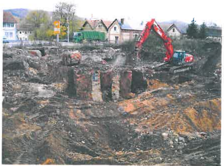
Stemmarbeiten an z.T. Belasteten Fundamenten 04.11.2008
