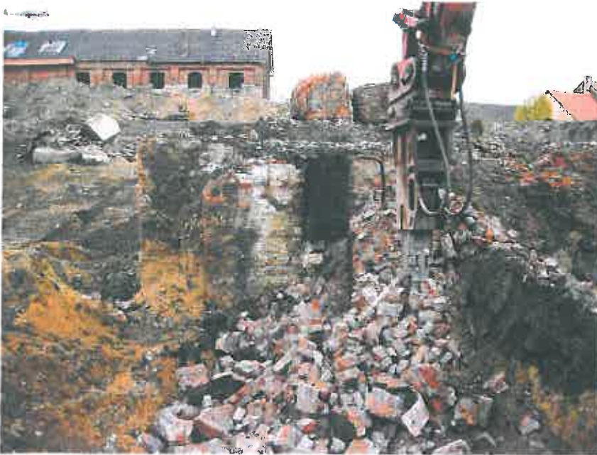
Stemmarbeiten an z.T. Belasteten Fundamenten 04.11.2008
