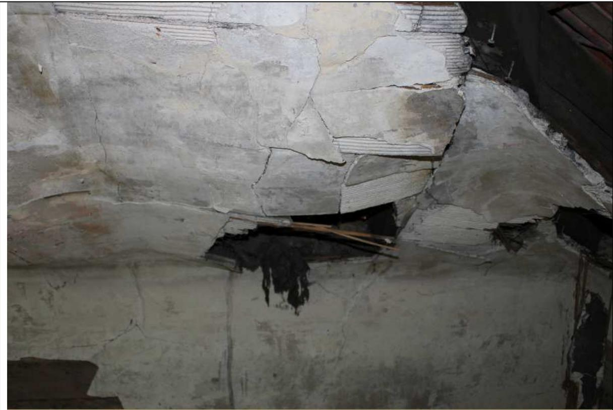
Foto 5: Rohrmattendecke im Dachstuhl des Gebäudes „Konstruktion“
