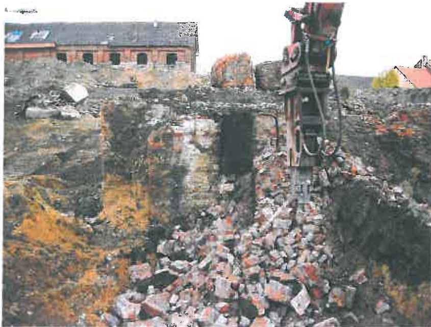
Stemmarbeiten an z.T. Belasteten Fundamenten 04.11.2008
