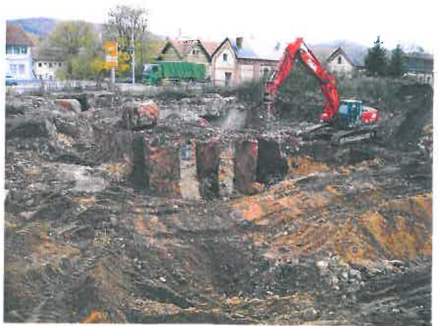
Stemmarbeiten an z.T. Belasteten Fundamenten 04.11.2008
