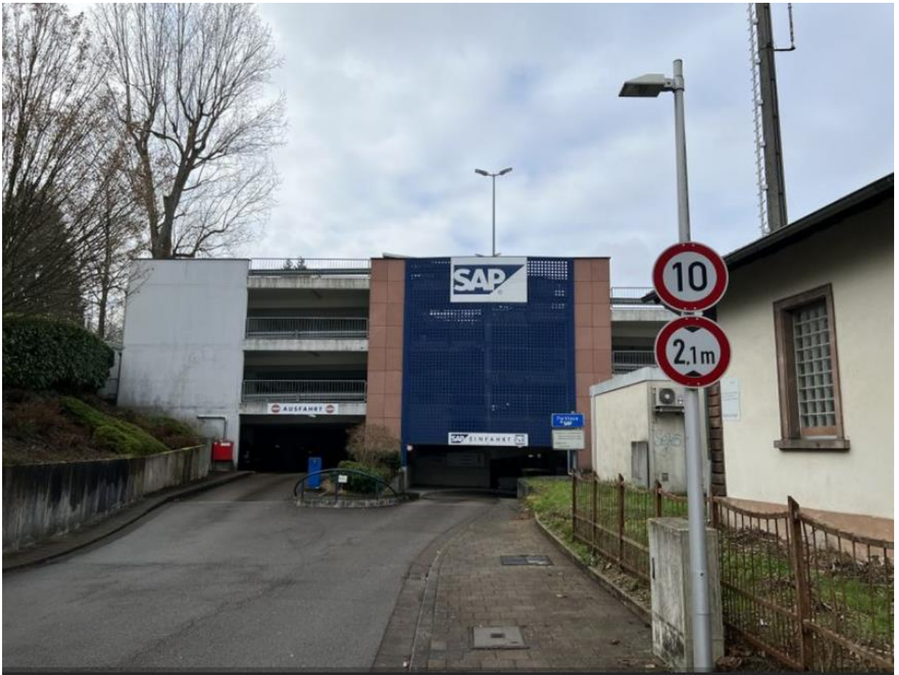
Abbildung 1: Aufnahme des Parkhauses
