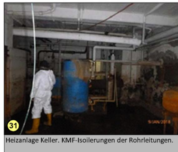
31 Heizanlage Keller. KMF-Isolierungen der Rohrleitungen. 9/JAN/2018
