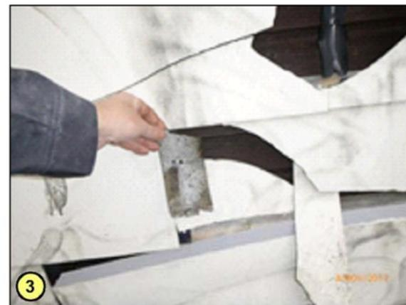
3 Fassade - Dichtpappe über Stößen der Unterkonstruktion.
