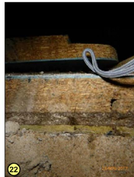
22 Fußbodenaufbau mit KMF-Trittschalldämmung und asbesthaltiger Trennschicht (Pfeil). 11/NOV/2017
