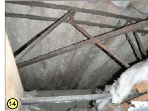
14 Hallendach: Eternitplatten, Stahlträger, KMF-Dämmwolle, Holz, Gipsplatten.
