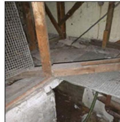
18 Unter Tribüne: Betonbodenplatte und unterirdischer Kanal aus Hüttenstein-Mauerwerk (lose KMF). 9/NOV/2017
