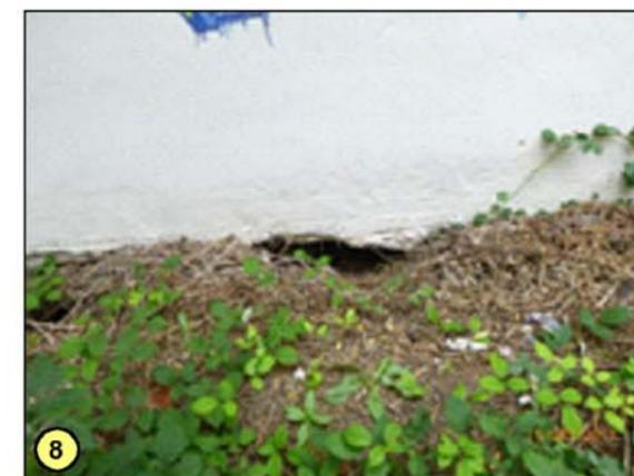
8 Ausspülung unter Südwand durch Rohrbach (Zugangsmöglichkeit für Füchse).
