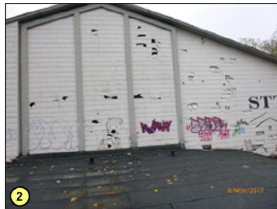
2 Fassade der Halle mit zerbrochenen Faserzementplatten (Bruchstücke auf Dach des Anbaus). Fenster mit verkleidet.
