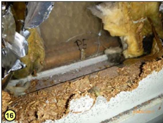
16 Seitenfenster: Holzverkleidung Innen und außen, KMF-Dämmung. P5 - asbesthaltiger Fensterkitt. 9/NOV/2017
