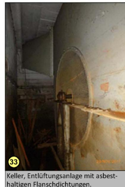
33 Keller, Entlüftungsanlage mit asbesthaltigen Flanschdichtungen. 23/NOV/2017
