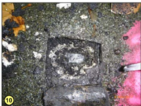
10 Dach des Anbaus: Dichtbahnen und Styropordämmung.
