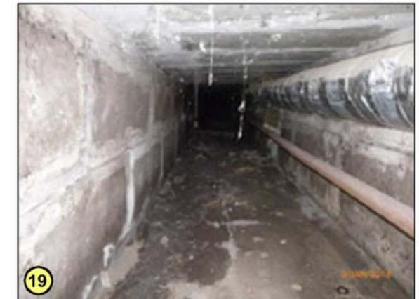
19 Kanal unter Tribüne mit 1 cm EPS-Dämmung. Boden unbefestigt (lose KMF). 9/JAN/2018
