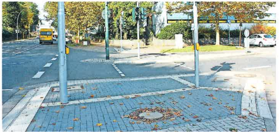
Fehlerhafte Leitlinien mit Ampelposten mitten auf den Bodenindikatoren an der Kreuzung Poststraße / Schlachthofstraße.
