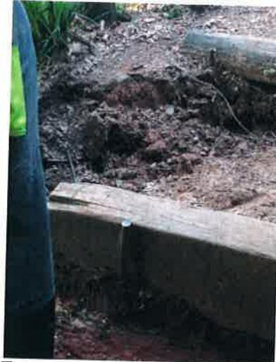
Foto 15, defekte Treppenstufe mit Rundeisen
