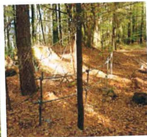
31. Zaun aus Rundstahl mit unbehandelter Oberfläche, genau angepasst an die Form des ehemaligen Bunkers. Der Zaun passt farblich in die Umgebung und fällt kaum auf. Je nach Umfeld und Geradheit oder Rundung des Zauns betragen die Kosten zwischen 200 und 400 €/lfm, die Haltbarkeit liegt vermutlich bei weit über 30 Jahren und die technischen Möglichkeiten (Einbau von Rundungen) sind größer als beim Quadratrohr. Durchführung: Metallwerkstätte Scharly. Foto: BUND RLP
