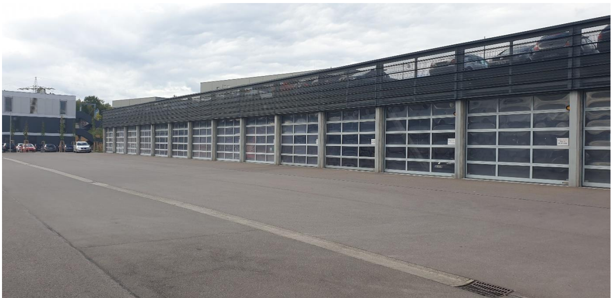
Abbildung 23: Abstellhalle Sophie-Krämer-Str. (Frontsicht)
